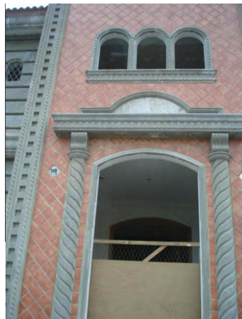
Construcción en Culiacán, Sinaloa, 2005
