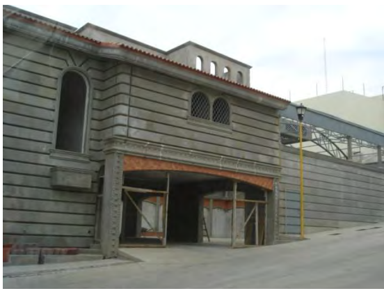
Construcción en Culiacán, Sinaloa, 2005
