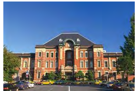
Estación de Tokio construido con ladrillo[5]
