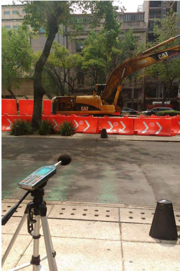
Foto: Punto de medición Maquinaria pesada en funcionamiento, frente a Torre Cuarzo.
