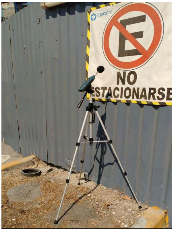
Foto: Punto de medición Torre Punto Chapultepec, punto de referencia, medición de un Generador de Energía.
