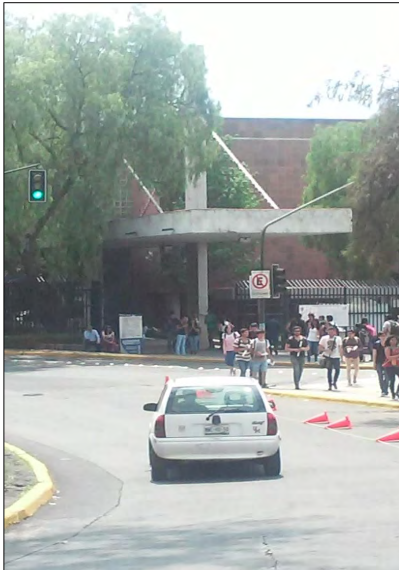
Imagen 1.1. Acceso principal del Anexo de Ingeniería y vista de la estructura atirantada
