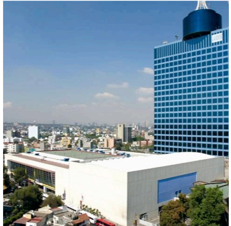
Imagen 8. Fachada Centro Internacional de Exposiciones y Convenciones World Trade Center. [8].
