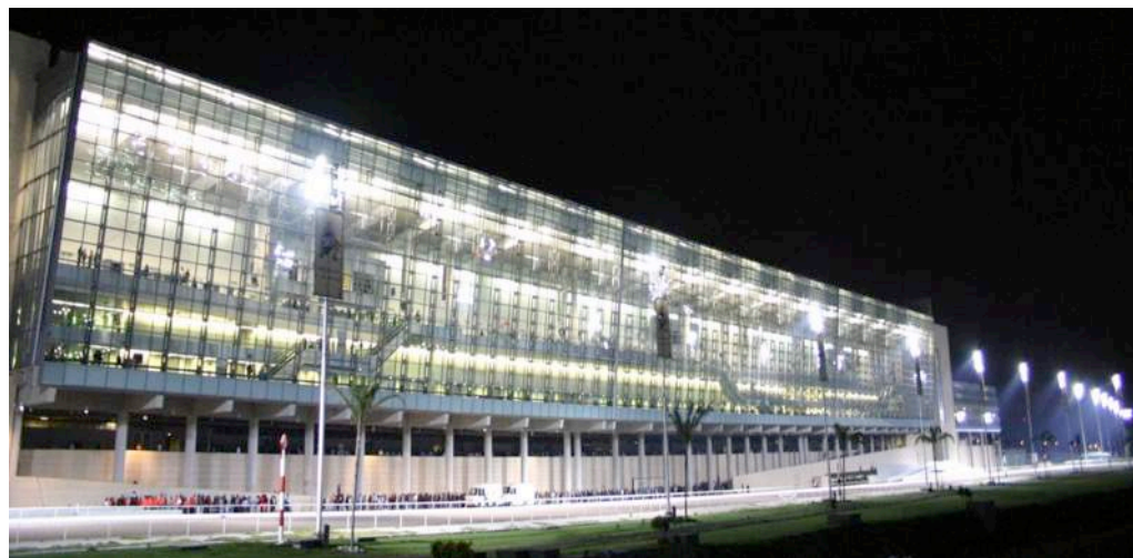
Imagen 18. Fachada Centro Banamex vista desde el Hipódromo de las Américas. [13].
