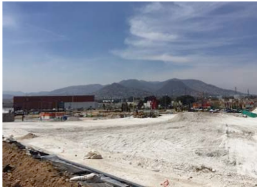
Imagen 57. Terreno, Foto 3. Vista al poniente. [26]
