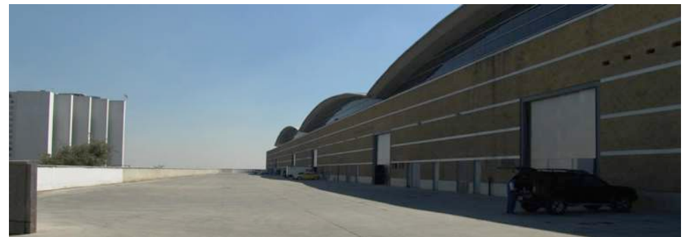
Imagen 33. Vista Acceso de Carga y Servicios Expo Santa Fe México. [17]
