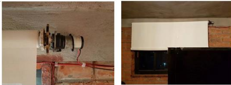
Ilustración 60 Motor acoplado a persiana
