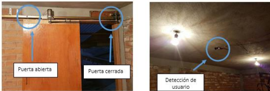
Ilustración 59 Ubicación de sensores (puerta abierta, puerta cerrada y detección de usuario)
