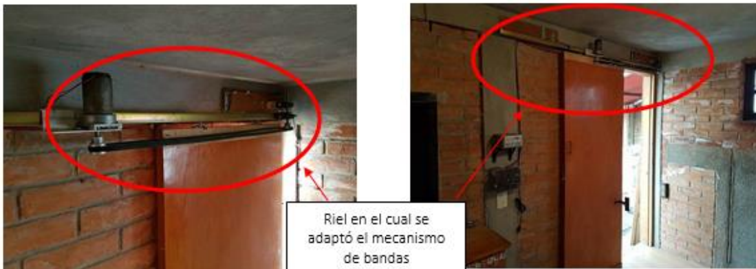
Ilustración 53 Adaptación de puerta corrediza
