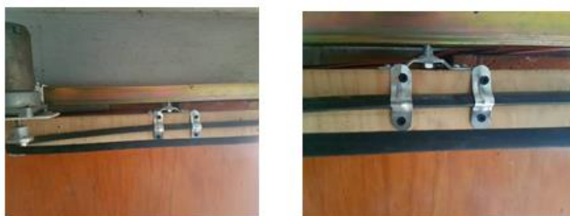
Ilustración 55 placas fijadas a la puerta junto con la banda
