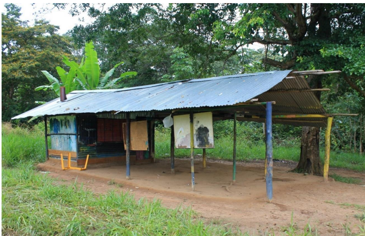
Escuela y comedor. Asentamiento de Agua Bonita. 25 de junio 2015. Foto personal.
