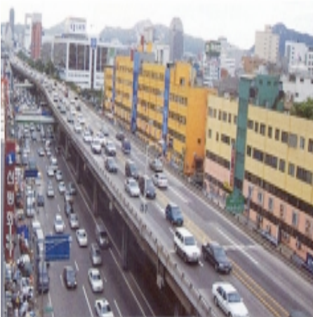
FOTO 38 – RECUPERACIÓN DEL CANAL CHEONGGYECHEON
