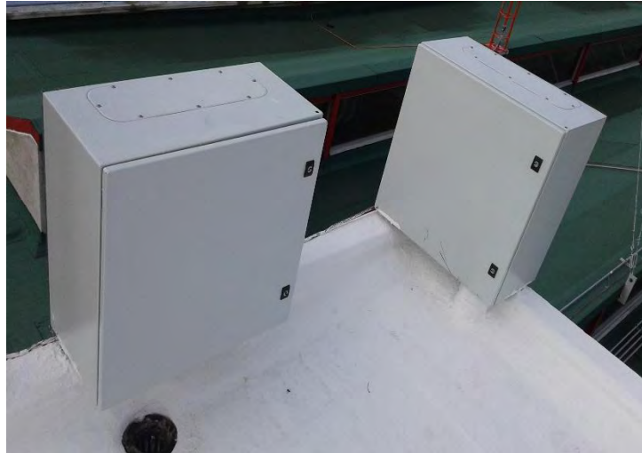
Figura 5.19 Registros para la energía eléctrica
