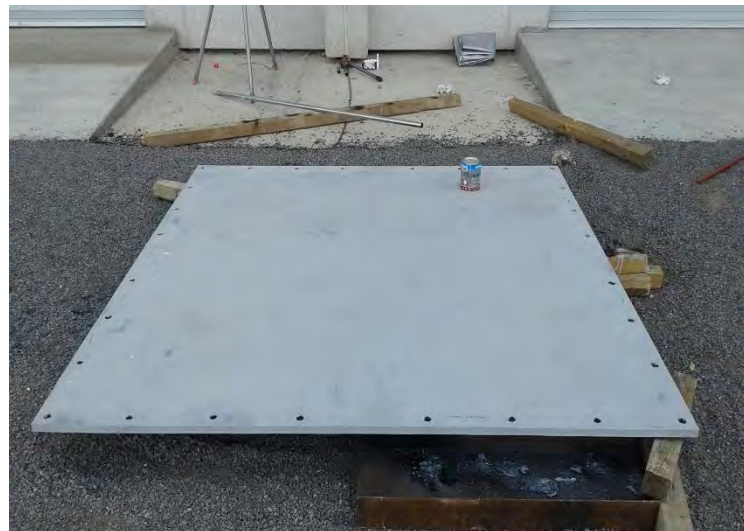
Figura.5.14 Placa para la base de la antena
