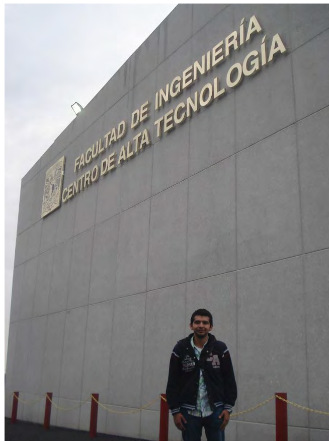
Figura 5.12 Edificio de la unidad de Alta Tecnología en Juriquilla, Querétaro
