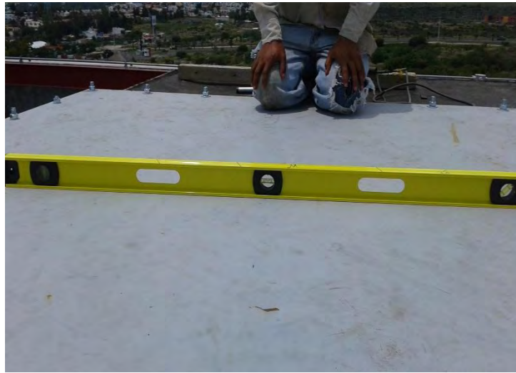
Figura 5.15 Comprobar el nivel de la base de la antena
