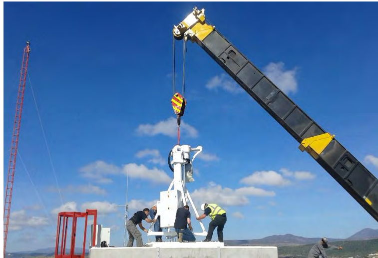
Figura 5.21 Instalación del pedestal
