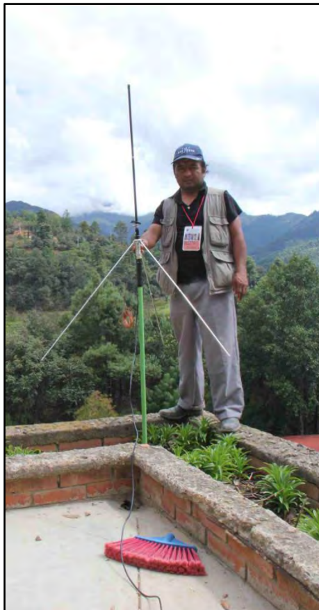
Imagen 1. Técnico instalando antena en palo de escoba.
