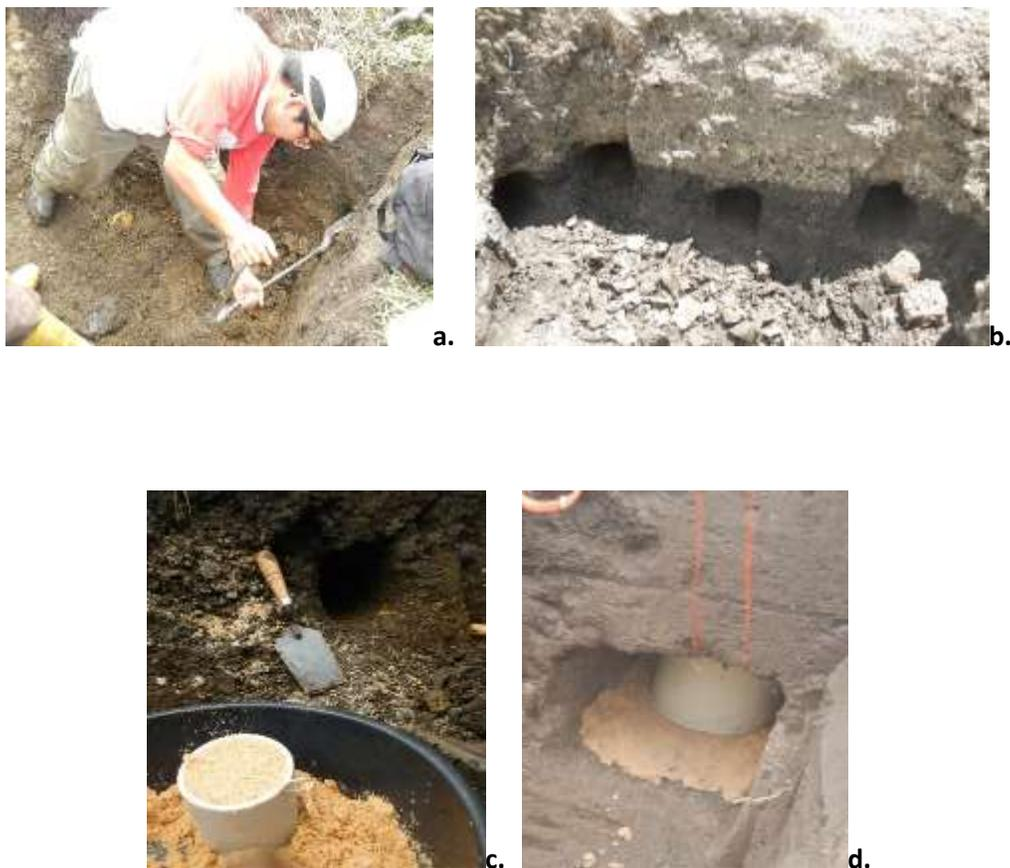
*Figura 14. a y b Construcción de los túneles de instalación, c. Cuadrar y elaborar el techo del túnel y d. Instalación de los contenedores.*
