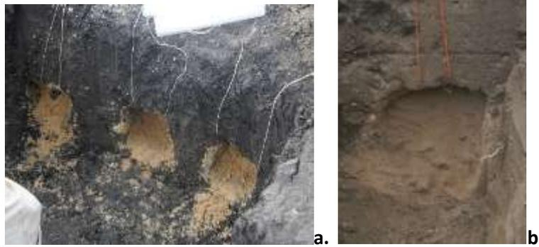
Figura 15. **a y b** Cierre de los túneles con arena sílica y por último con suelo.
