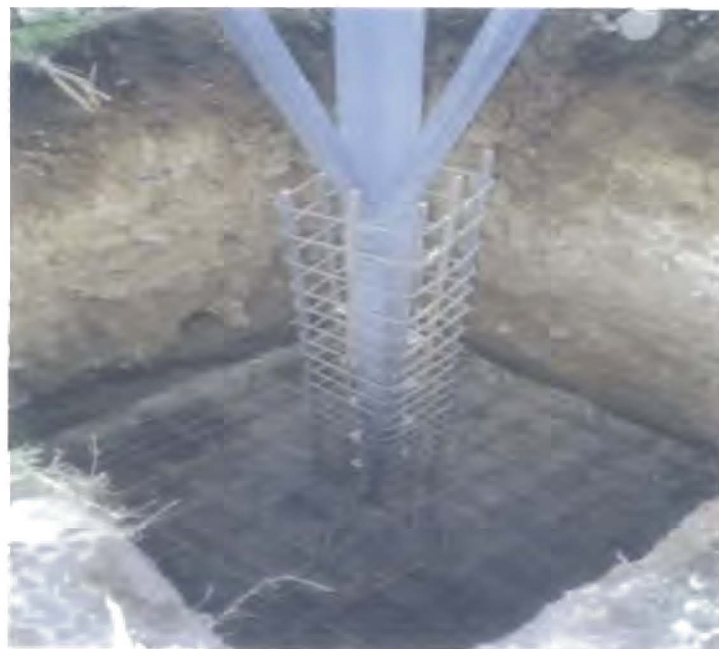
Figura IV:6.1. Armado de la zapata y del dado para colar monticamente la cimentación de la torre No.16 en el Km 6+375. Observese la colocación del Stub y la Pata ahogados dentro del dado.
