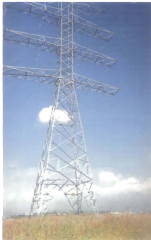
Figura IV.12.2 Estructura de Entronque desde otro ángulo.
