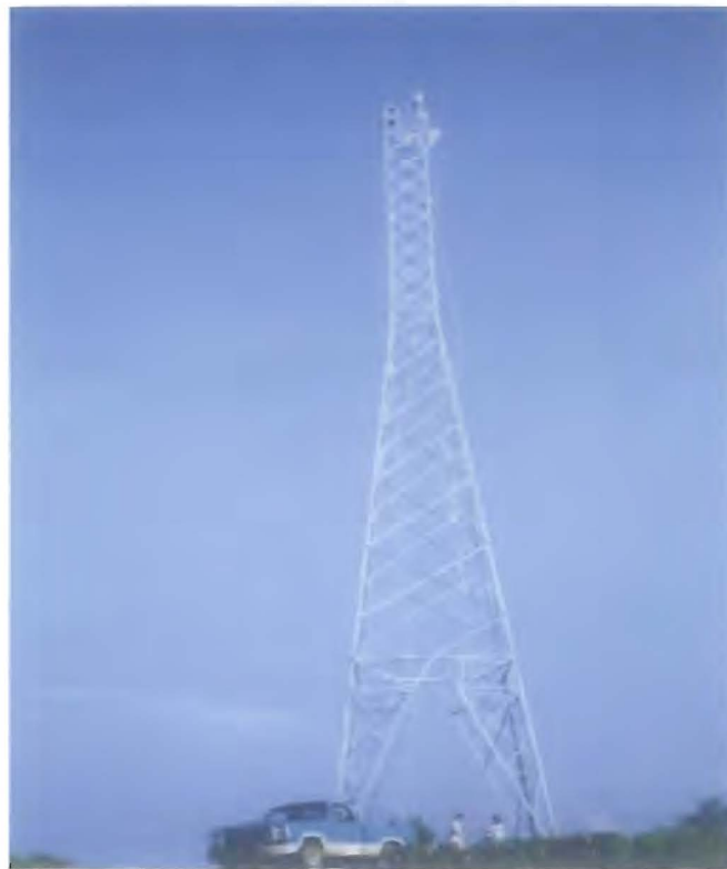
Figura No. IV.10.2 Torre No.13 Obsérvese el Bottom- Panel (1er tercio) el cuerpo piramidal (2 tercio) y la linternilla (3er tercio).
