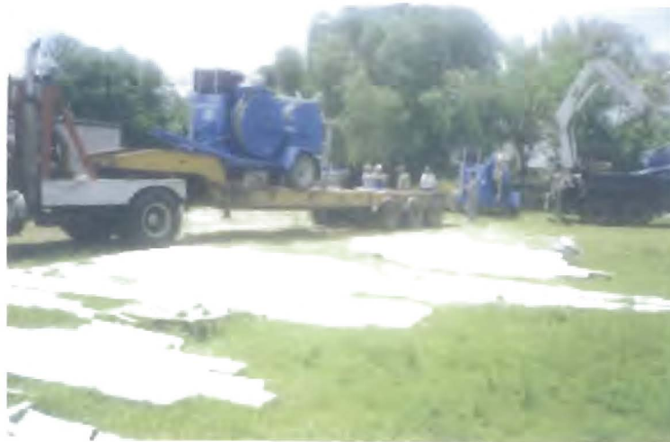
Figura No. IV.10.1 Separación de piezas de una parte de la torre No.8
