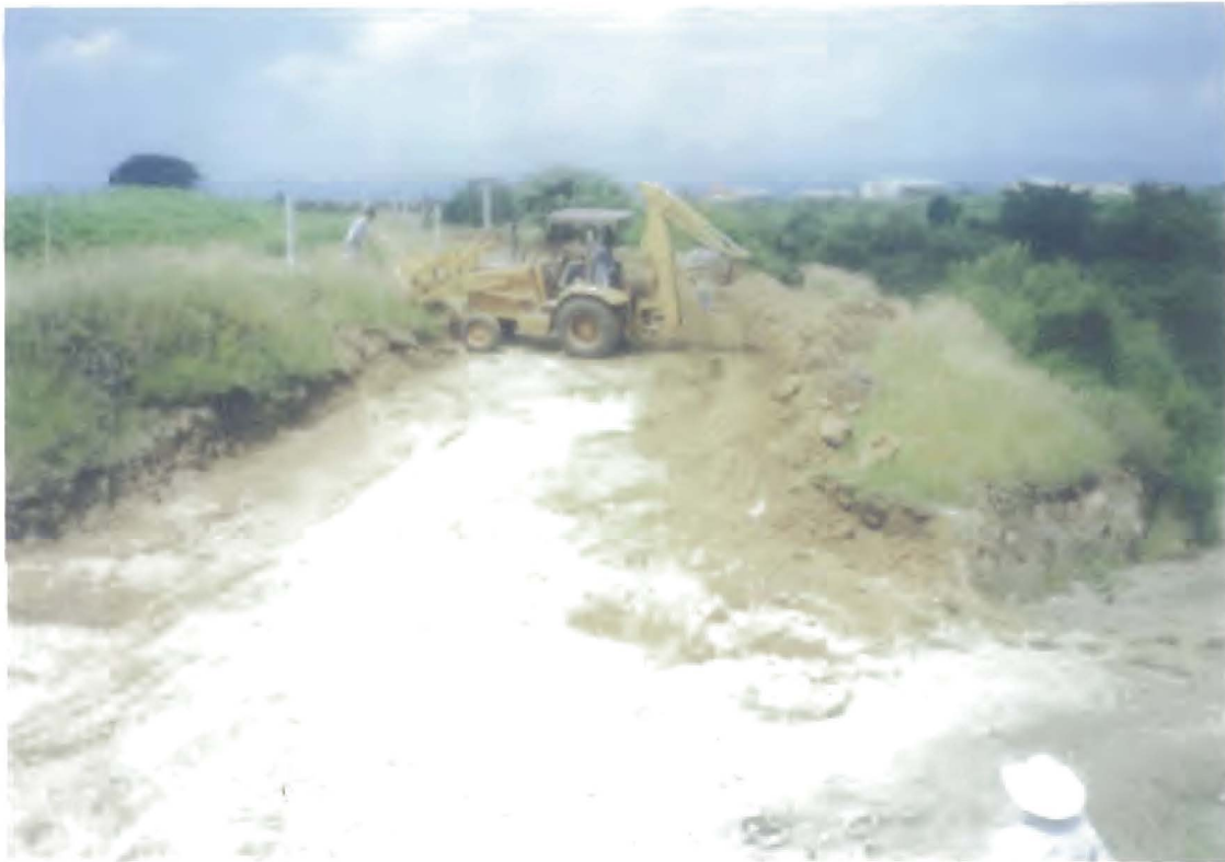
Figura IV.4.1.-Construcción del acceso a la torre No.18 localizada en el Km 7+350
