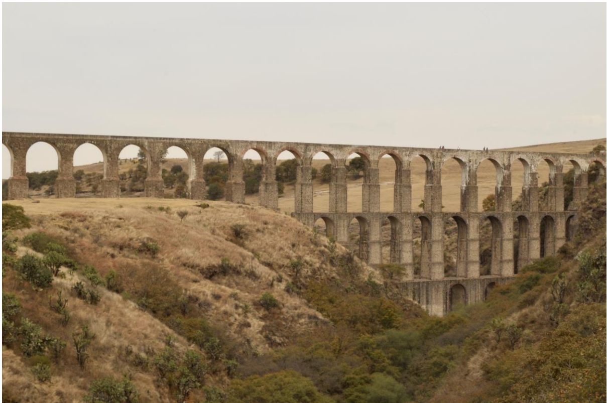
Figura 25. Arcos representativos de la zona de estudio, formaron parte de un acueducto que data de la época colonial con objetivo de llevar agua de la sierra a la Hacienda de Xalpa.
