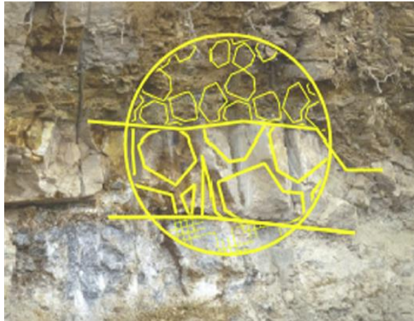
Fig. 1.5. Frente de excavación de material mixto en una Interface roca-suelo 26
