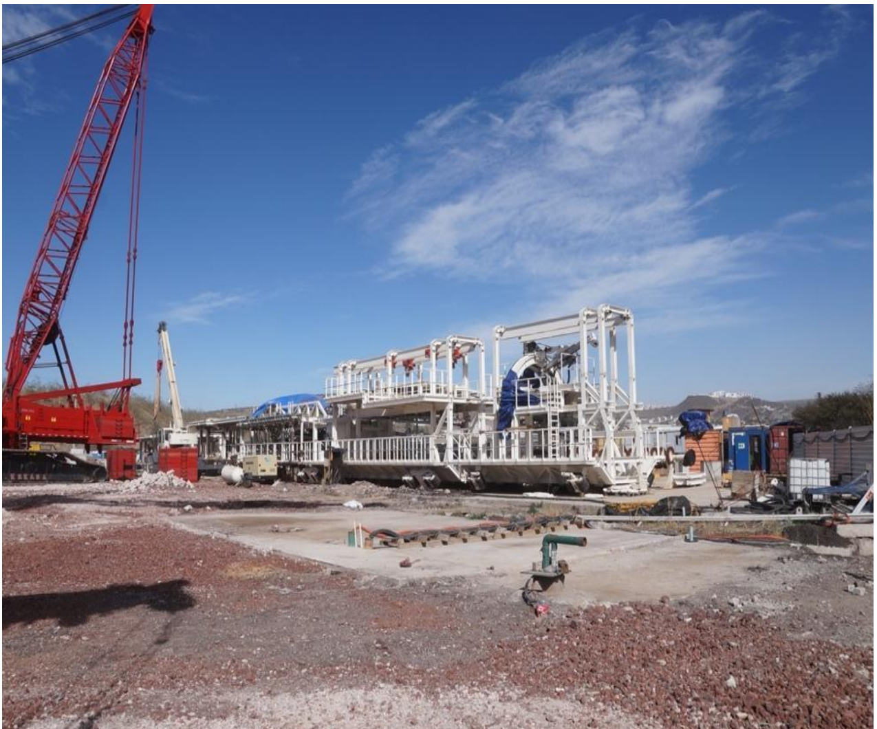
Fig. 3.9. Armado de carros de la TBM en superficie. 92
