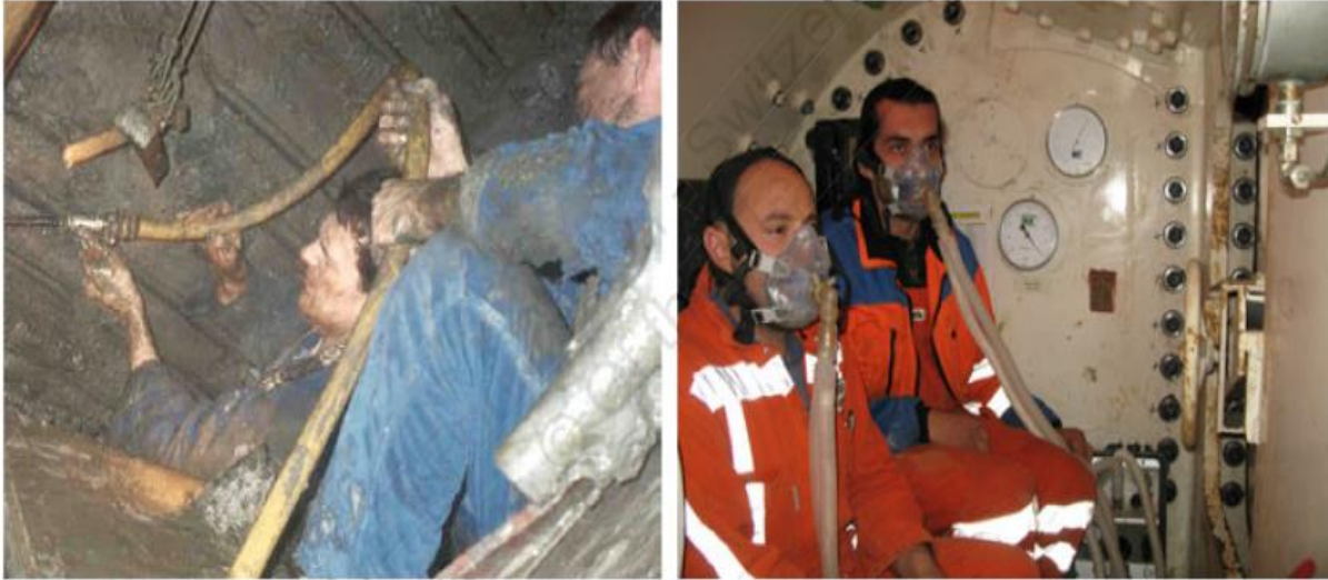
Fig. 3.7. Ejemplo de trabajos en cámaras Hiperbáricas. 78
