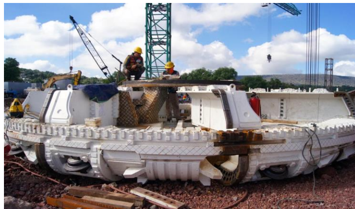
Fig. 2.1. Preparación de la cabeza de corte de la TBM para ser bajada con grúa. 55
