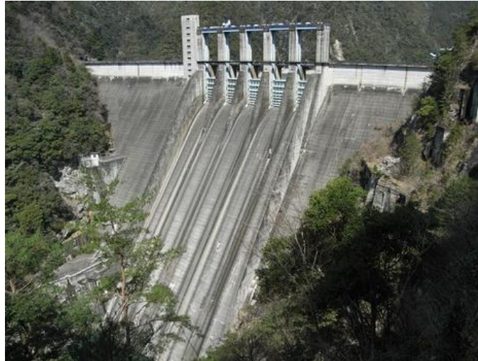
Figura 10. Imagen de la presa Sakuma, Japón ( www.structurae.com )
