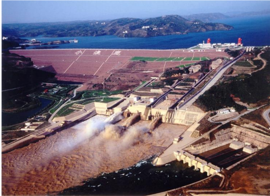
Figura 5. Presa Xiao Lang Di, China durante una ejecución del flushing. ( www.crviewer.com )
