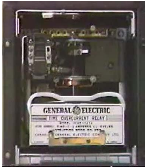
30 Figura 4.9.1 Relevador electromecánico.
