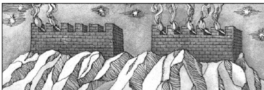
Figura 1. Estación receptora y transmisora del telégrafo de fuego Fuente: Szymanczyk, O., "Historia de las telecomunicaciones mundiales".
