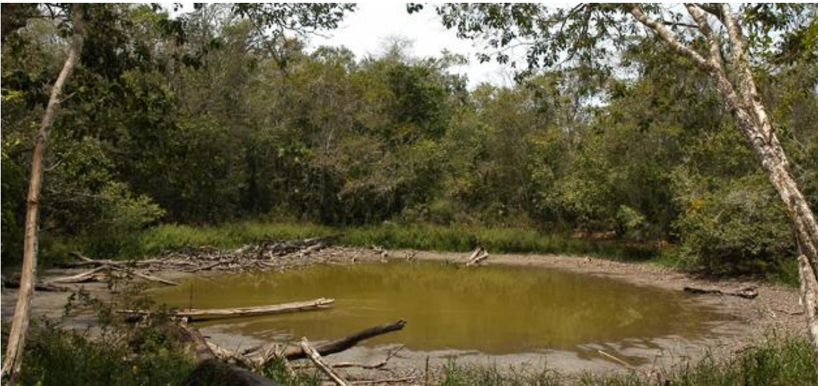
Figura 5-3 Vista general de una aguada. Se observa la problemática de la falta de capacidad debido al azolve y arrastre de material orgánico.
