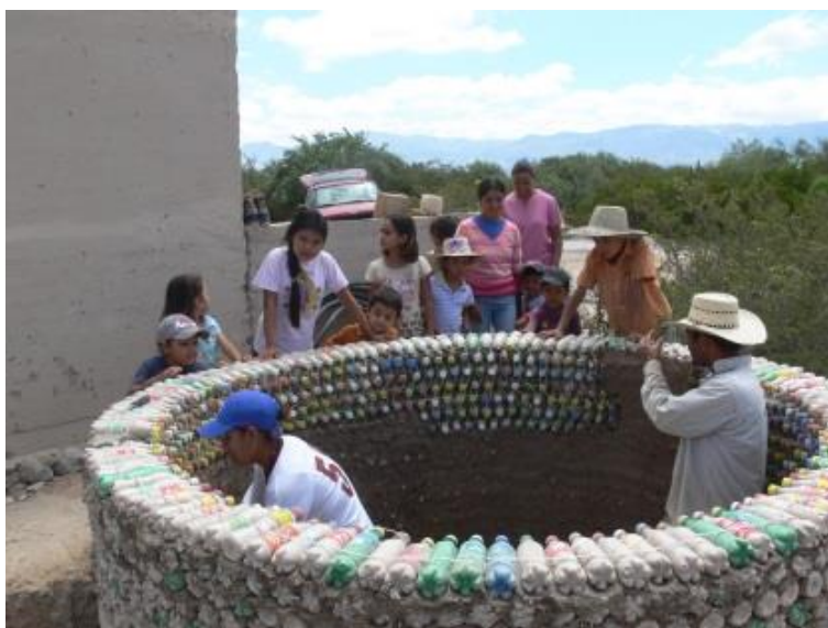
Figura 6-17 Cisterna de 6,000 lts. Construida con botellas de PET, ejido Las Margaritas, estado de San Luis Potosí.
