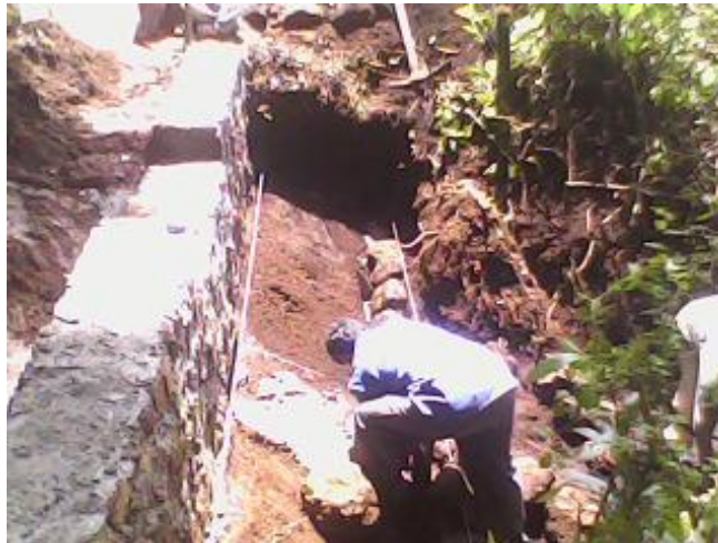
Figura 6-6 Cabeceo cárcava en proceso de construcción, microcuenca de San Juanito, ejido San Juan, Edo. México.
