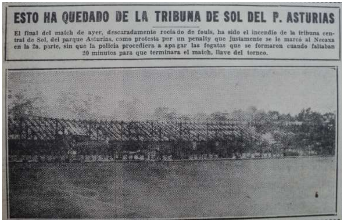
Imagen 3.6. Restos de estructura metálica de la tribuna del Parque Asturias. Excélsior , 27 de marzo 1939, 2ª sección, p.4.
