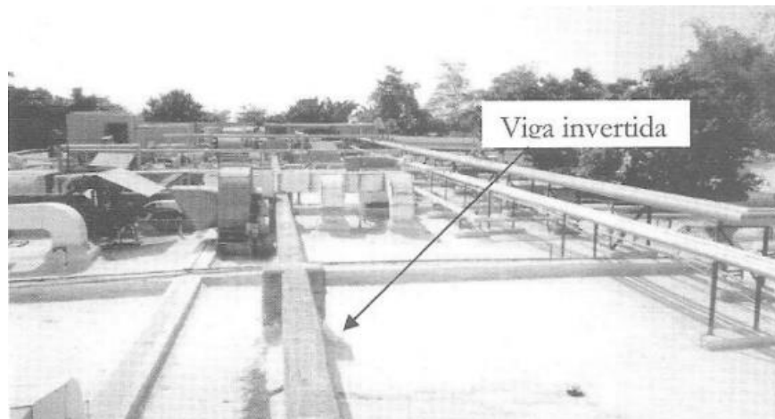
Figura 2.22 Trabes invertidas agregadas después del sismo de 1995
