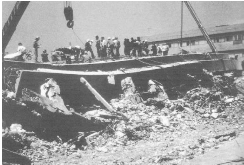
Figura 2.16 Derrumbe en el Hospital General (Salcido, 2010)
