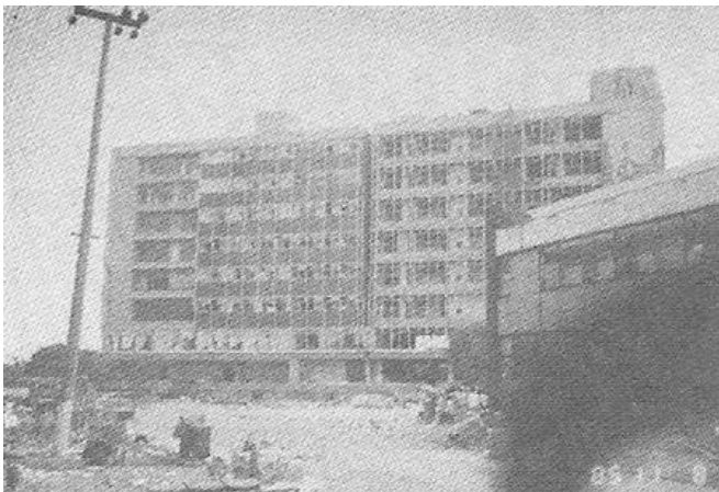
Figura 2.9 Edificio 246. La estructura de la izquierda es la A y la de la derecha la B
