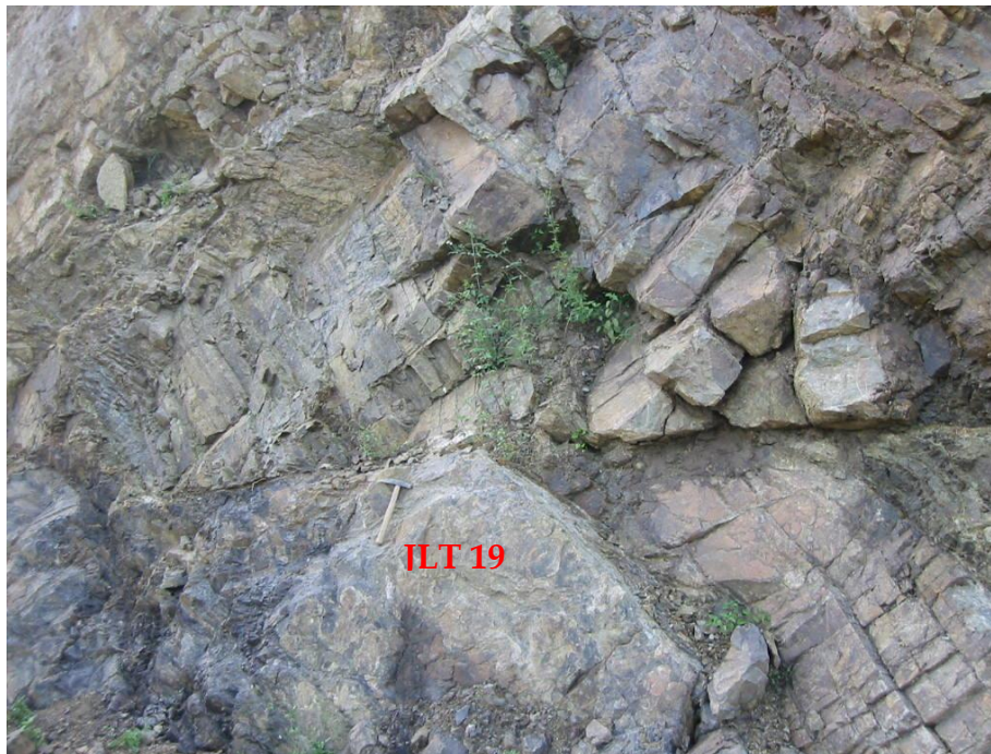
Figura 13. Afloramiento de andesita altamente fracturada y alterada que aflora en el poblado Agua Escondida.
