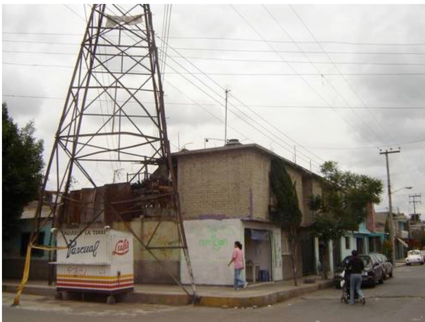
imagen 22. Vivienda informal en líneas de alta tensión..
