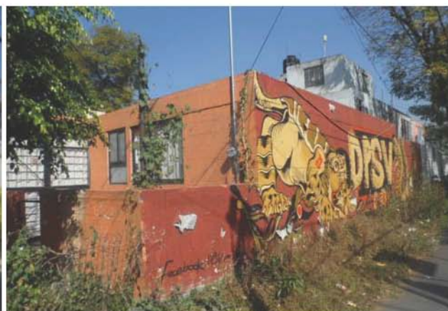
Ilustración 4.23 Integración del graffiti en fachadas, sobre de andadores en Unidad ISSSTE Fotografías propias
