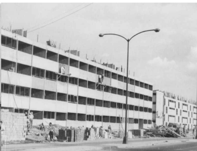
Ilustración 3.24 Proceso de construcción del Conjunto Urbano John F. Kennedy . Archivo Fotográfico de los Hermanos Mayo
