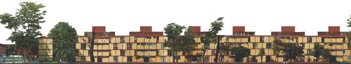
Unidad Habitacional John F. Kennedy vista de calle Nicolás León
