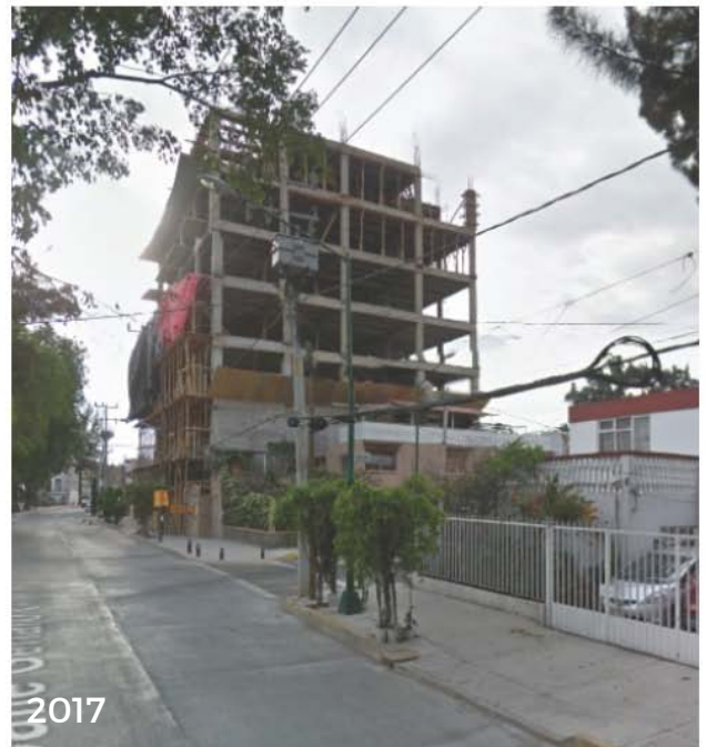
Ilustración 4.20 Construcciones nuevas sobre Genaro García Street view Google Maps
