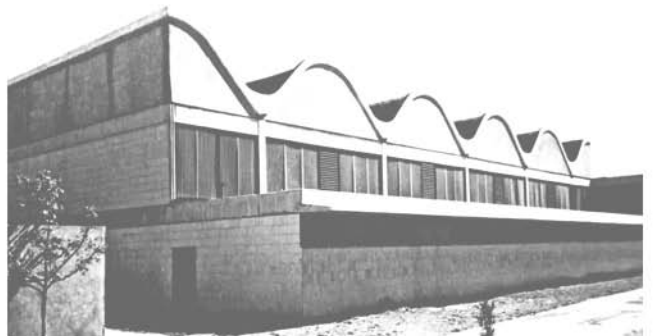
Ilustración 3.27 Fachada lateral de Tienda No. 22 del ISSSTE
