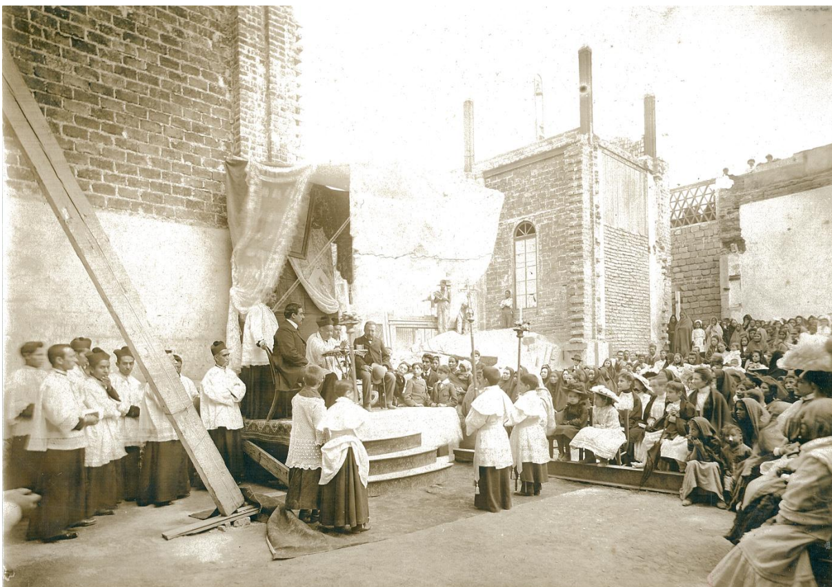
Colocación de la primera vigueta de hierro Fuente: Archivo General de los Misioneros Josefinos
