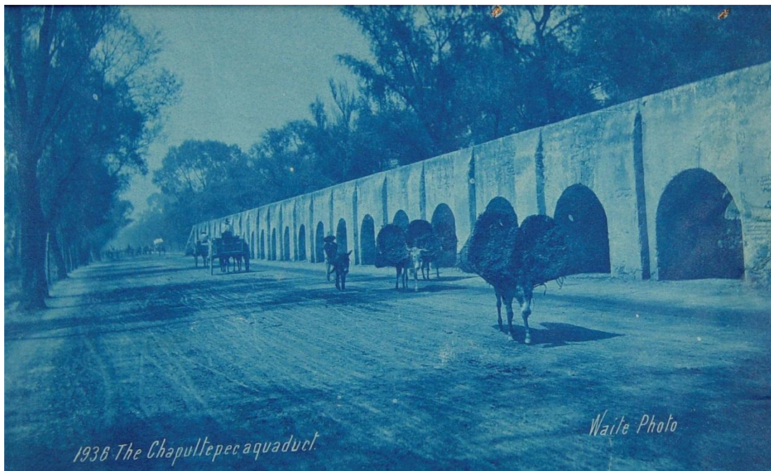
Acueducto Chapultepec, fot. C. B. Waite, 1936 Fuente: Antigua Academia de San Carlos
