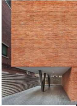
Muro de 14 y 38 cm de espesor, de tabique rojo recocido, asentado con mezcla cemento arena 1:4 acabado aparente.
