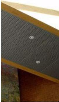
Plafón modular registrable perforado modelo Tile Snap-in, marca Hunter Douglas, color aluminio natural, colocado con sistema de suspensión para circulaciones y sanitarios.
