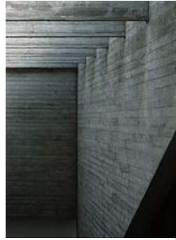
Muro de concreto armado  $f_c = 250 \text{ kg/cm}^2$  aparente con barrotes como cimbra utilizada colocados horizontalmente.
