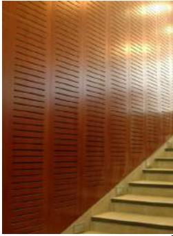
Revestimiento de madera perforado acústico de 16 mm, modelo Natura, marca Hunter Douglas, para auditorio.
