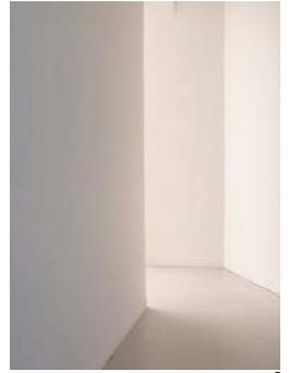
Fino de aplanado de 6 mm, en muros con yeso pulido. Dos manos de pintura blanca vinílica mate marca Comex.
