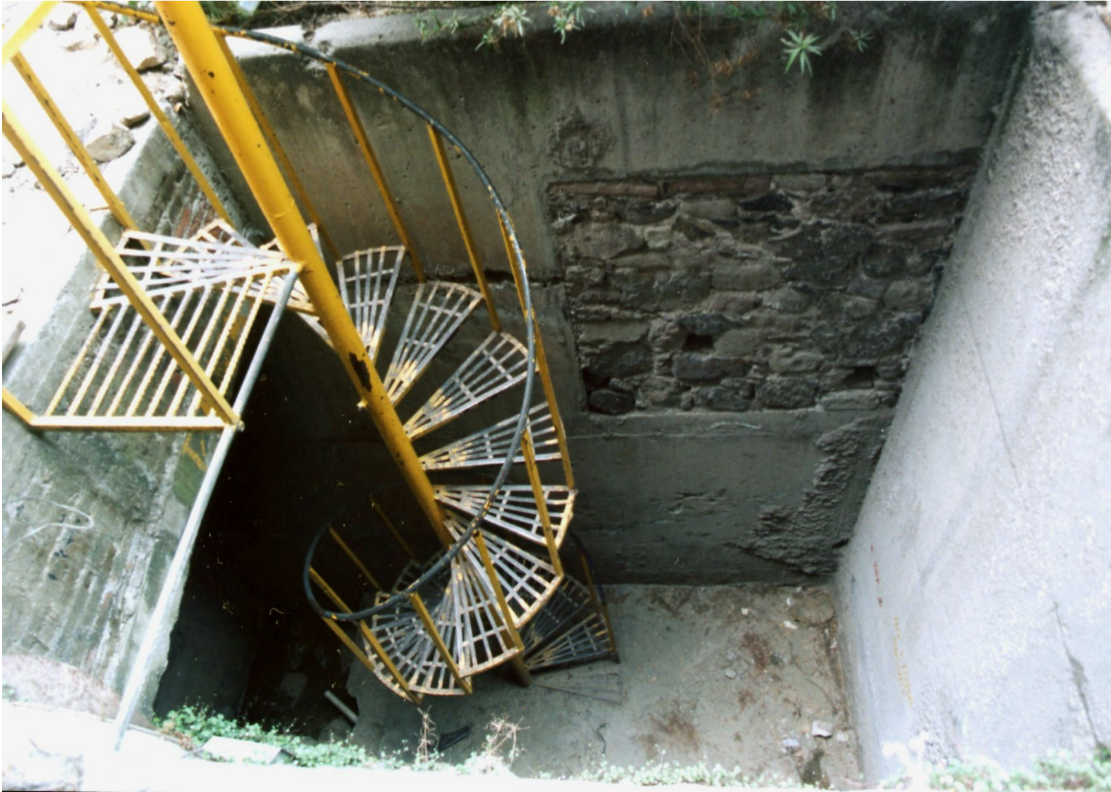
Estado actual del acceso por la zona arqueológica del Sagrario.
