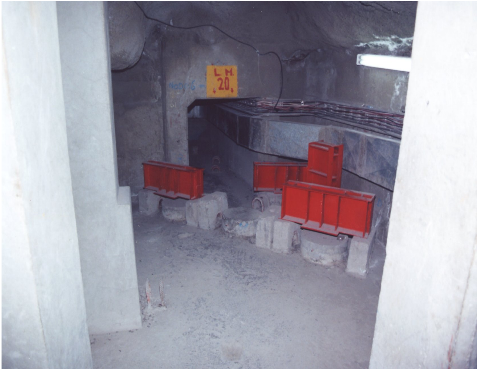
Estado actual del acceso por la zona arqueológica del Sagrario.
