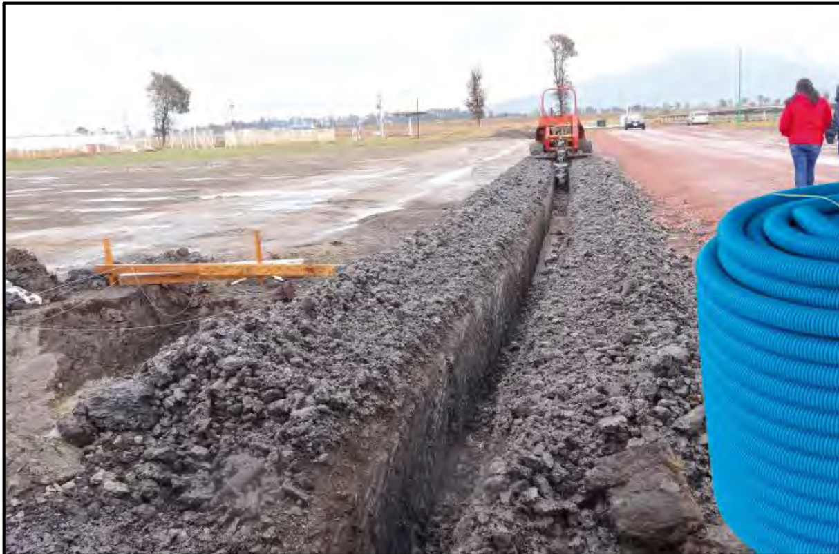
Ejemplo de canalización a cielo abierto
