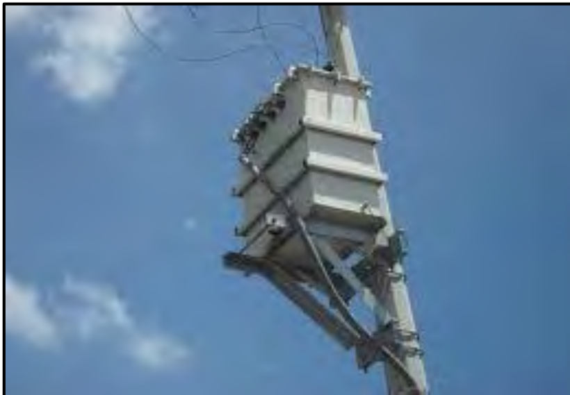
Figura 2.4 Transformador tipo poste
