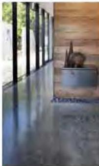
Firme de concreto armado  $f_c=250 \text{ kg/cm}^2$  acabado pulido para áreas interiores de servicio.
