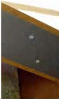
Plafón modular registrable perforado modelo Tile Snap-in, marca Hunter Douglas, color aluminio natural, colocado con sistema de suspensión para circulaciones y sanitarios.
