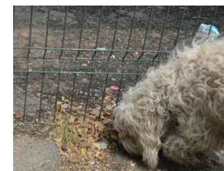
Imagen 3.81 La reja perimetral llega hasta el suelo para evitar que los perros se escapen por debajo
