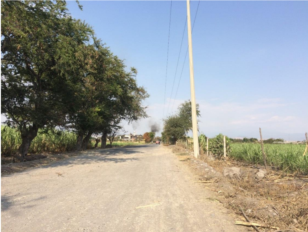
Ilustración 18. Inicio del camino km 0+000, unión con camino de conexión al Ingenio y CONAPLOR.
