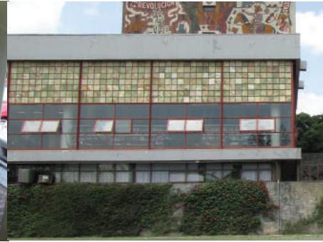
55. Fachada oriente de Biblioteca Central.
