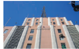
l. Edificio Miguel E. Abed
