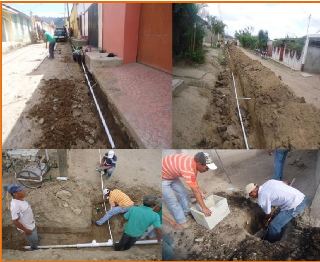
Imagen 3 Introducción de Redes de Agua Potable
