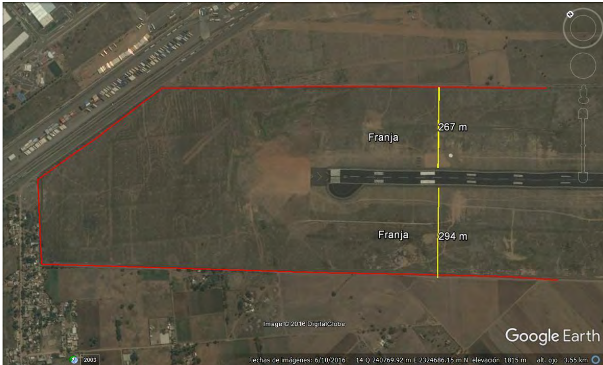
Imagen 20. Franja de pista en el Aeropuerto Internacional de Guanajuato
