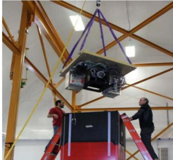
Figura 3.5: Integración mecánica de EUSO-Balloon [59].
