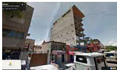
Construcción de 6 niveles sobre avenida Ahuanusco esquina con Cicalco demuestra el interés económico sobre la calidad del entorno urbano.
