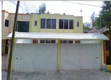
Fachada del inmueble
