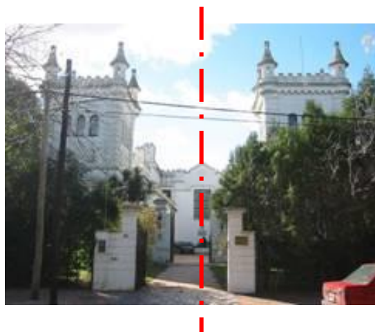
56. Fachada principal (sur)
