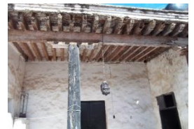
103. Sistema constructivo, bóveda catalana y vigas de madera
