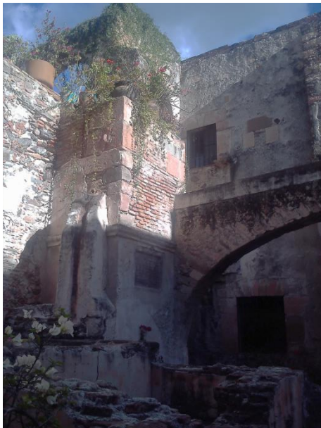
11. Desembocadura del acueducto de Querétaro, en el primer claustro del convento.
