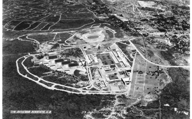
75. Fotografía del conjunto
