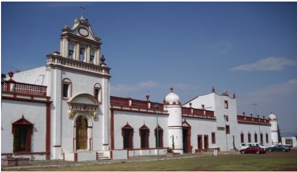
98. Fachada Sur Principal con arcos escarzanos y conopial.
