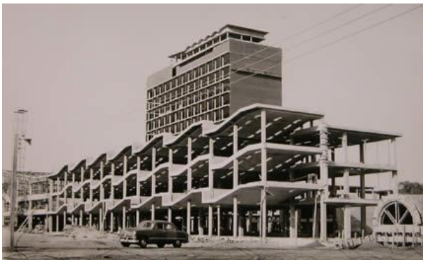
79. Construcción edificio de posgrado
