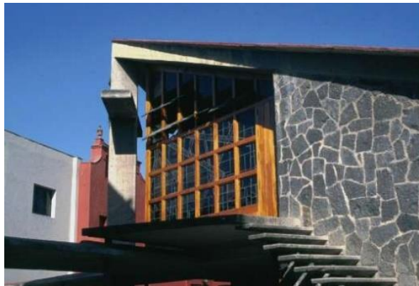
42. Escalera de concreto
