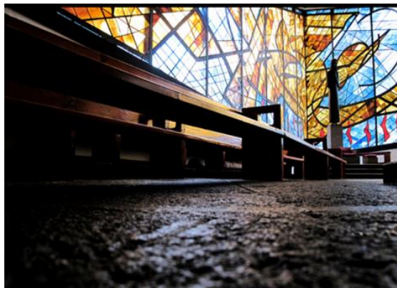
41. Vista del piso de piedra
