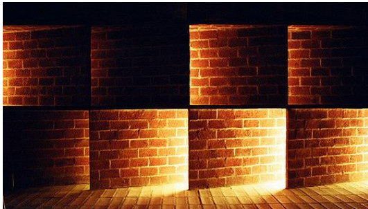
171. Muro del coro de la Iglesia de la Iglesia del Cristo Obrero, Atlántida, Uruguay.
