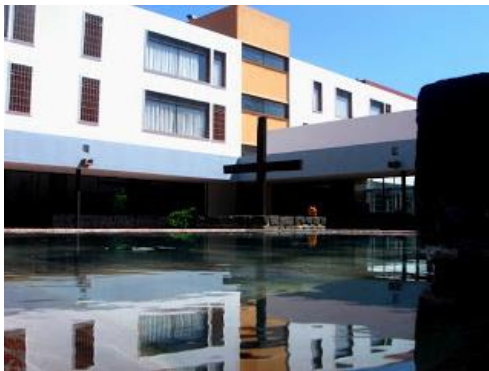
16. Patio Central / Claustro
