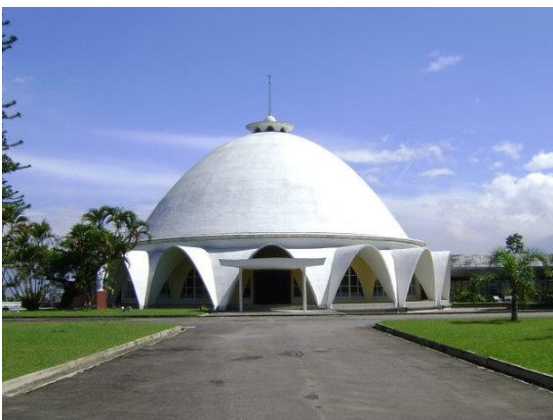
93. Fachada sur de la capilla
