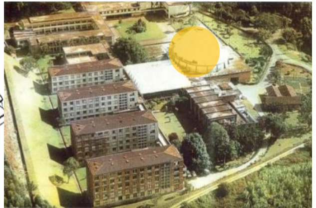
92. Fotografía del conjunto
