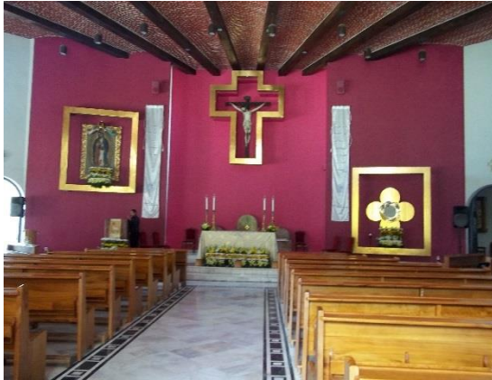
87. Capilla del seminario mayor. Cubierta echa de bóveda catalana, a base de ladrillo formando nervaduras que dirigen al altar dando ese énfasis, encontrando un muro en primer plano la cruz en segundo plano imágenes de la Virgen de Guadalupe.
