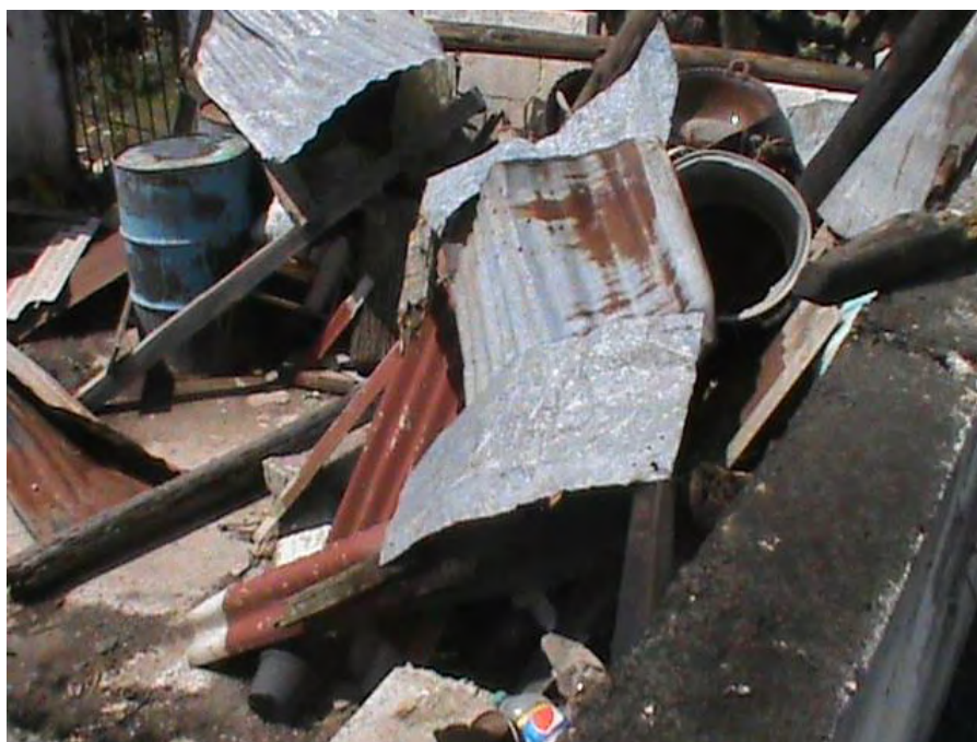
Imagen 12. Partes de láminas aventadas Fuente: Cortesía de Protección Civil de Acatlán
