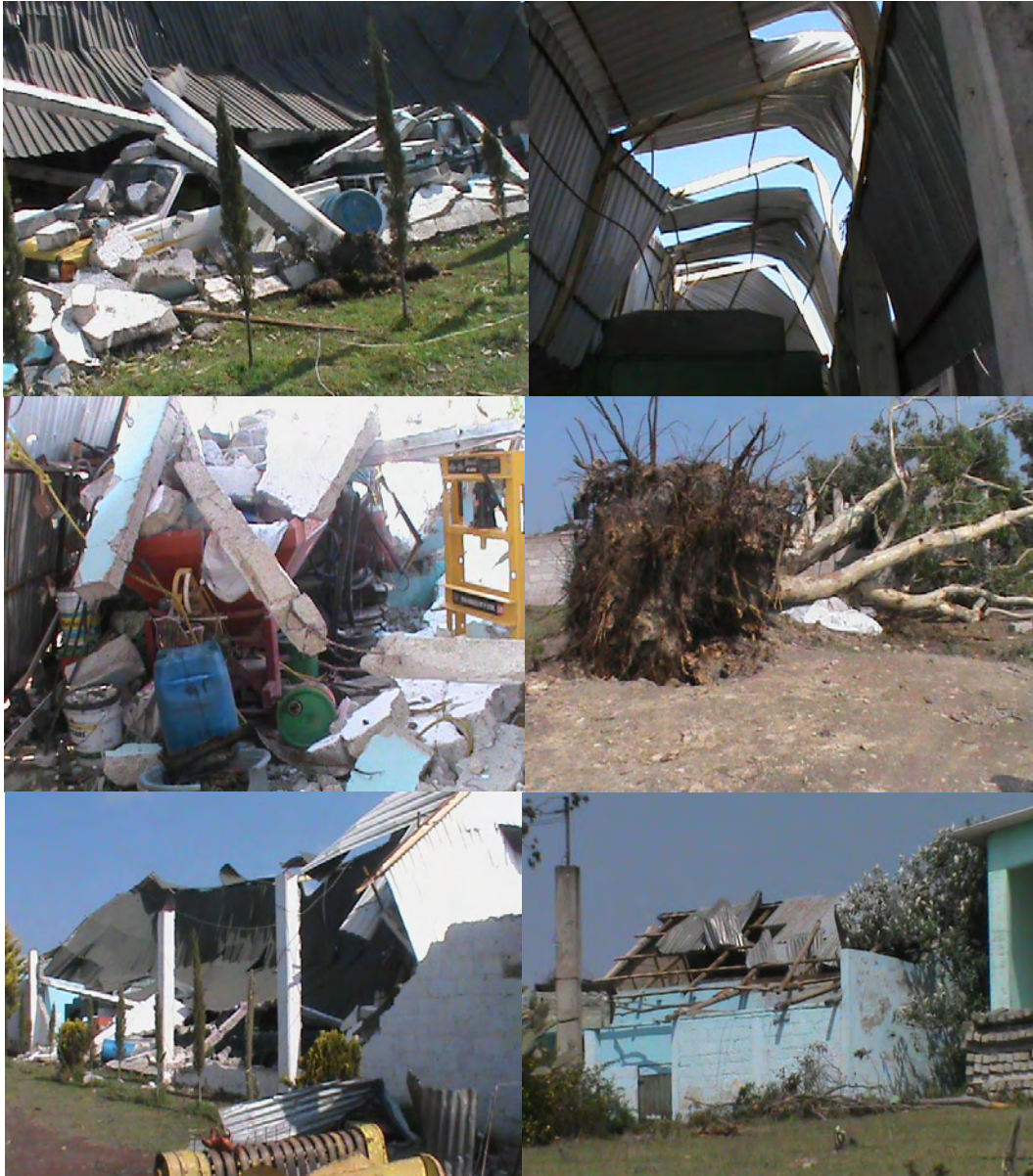
Figura 3.2 Fotografías de los daños del tornado de La Peñuela Fuente: Cortesía de Protección Civil de Acatlán
