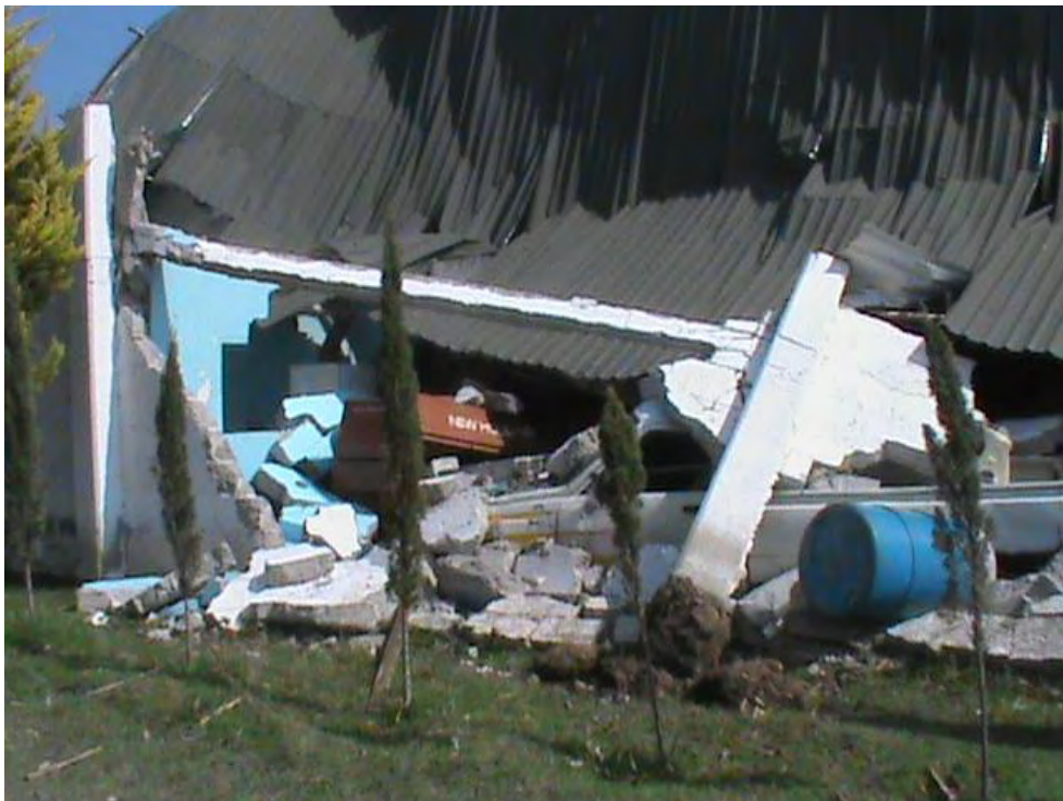
Imagen 4. Pared derribada por el paso del tornado Fuente: Cortesía de Protección Civil de Acatlán
