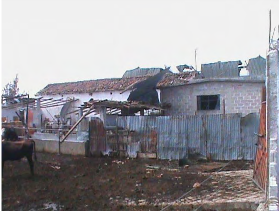
Imagen 7. Láminas dobladas y levantadas en el establo Fuente: Cortesía de Protección Civil de Acatlán
