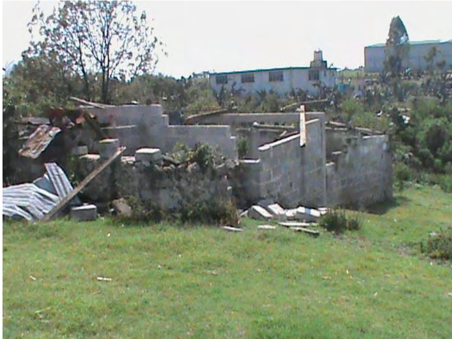
Imagen 16. Techos y paredes dañadas en una casa Fuente: Cortesía de Protección Civil de Acatlán
