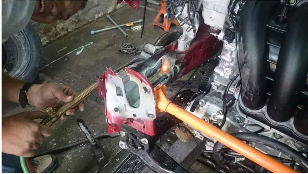
Fig.13 Calentando punta derecha con autogena y abriendo con el porto power.
