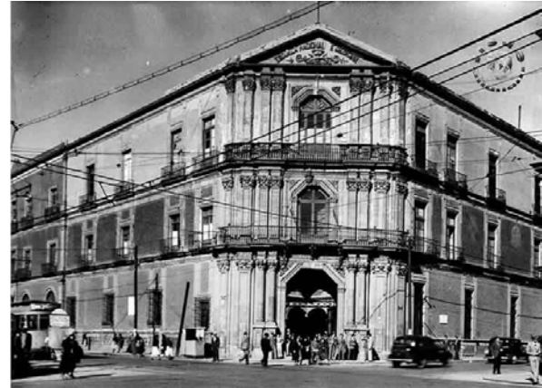
Fachada del edificio que albergó a la Escuela Nacional de Medicina, hoy Palacio de Medicina.
