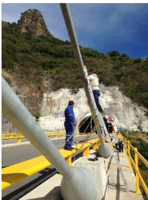
Figura 2.13 Instalación de acelerómetro en el Tirante 19 y de estación meteorológica
