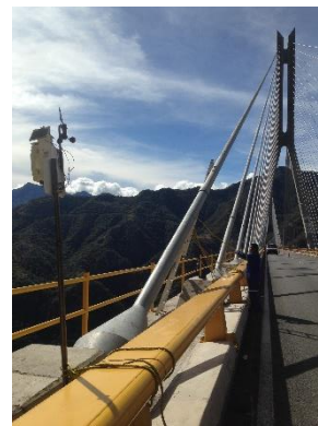
Figura 2.13 Instalación de acelerómetro en el Tirante 19 y de estación meteorológica
