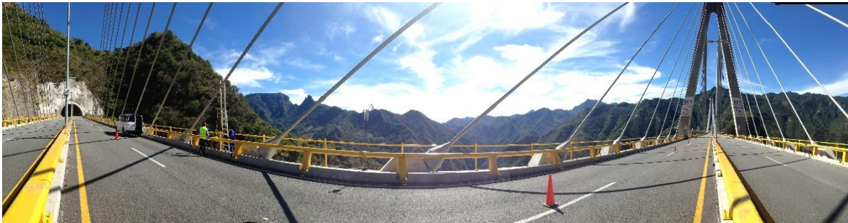
Figura 2.9. Vista panorámica de la zona de trabajo.
