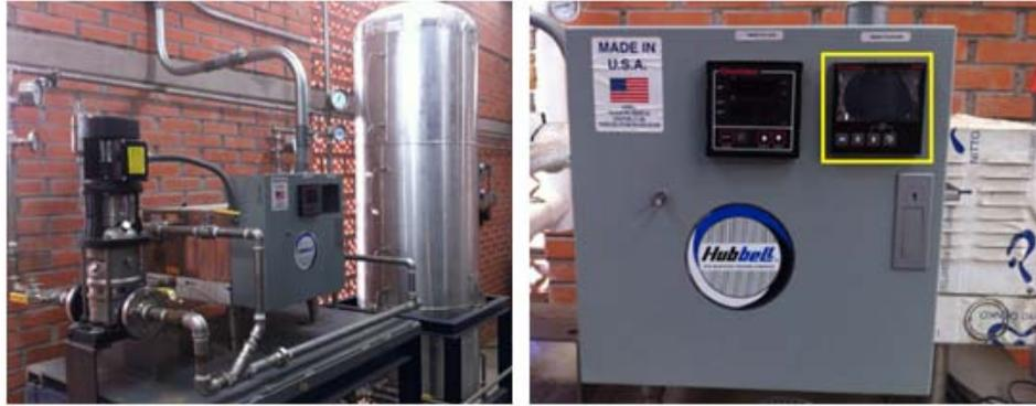
*Figura 4.32.- Control de la resistencia eléctrica y bomba vertical presentes en el sistema de calentamiento auxiliar.*
