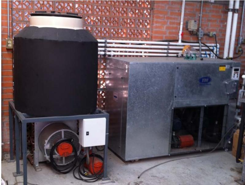
Figura 4.31.- Sistema de enfriamiento auxiliar compuesto por el enfriador y tanque de depósito.
