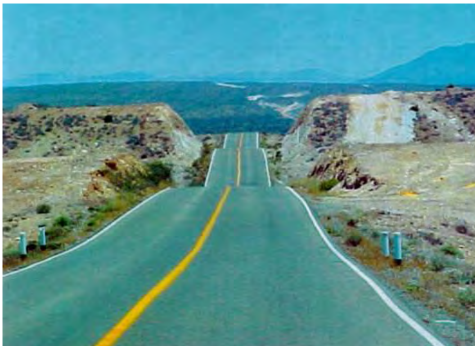
Figura 29. Puente Terrestre, tramo Carretera Transpeninsular.
