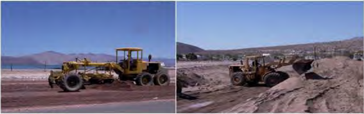
Figura 35. Bahía de los Ángeles. Obras Boulevard Paseo de los Ángeles. (FONATUR 2006)
