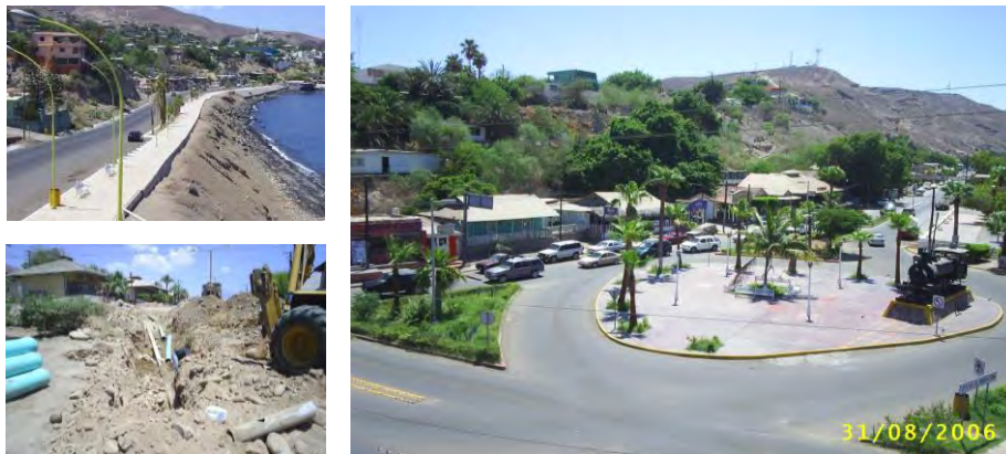
Figura 49. Santa Rosalía. Obras Acceso a la ciudad, agua potable y Glorieta Maquinita. (FONATUR 2006)
