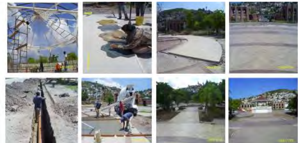
Figura 58. Topolobampo. Obras Plaza Principal. (FONATUR 2006)
