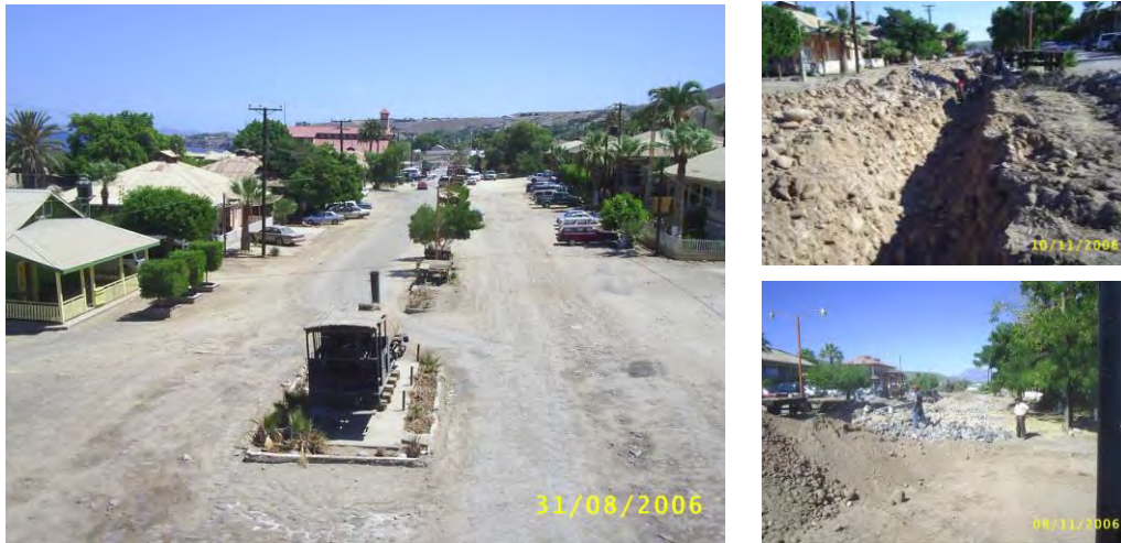
Figura 48. Santa Rosalía. Obras Mesa Francia. (FONATUR 2006)
