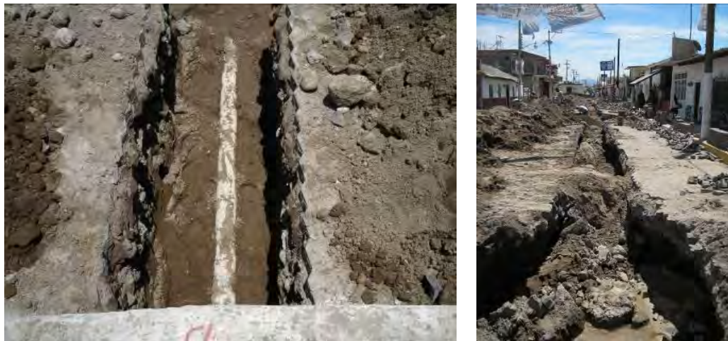
Figura 64. San Blas. Obras Andador Juárez. (FONATUR 2006)
