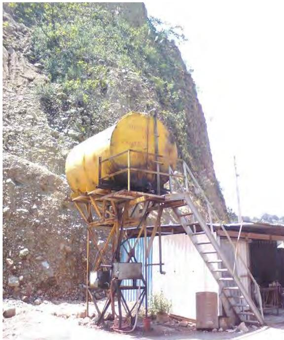
**Figura 9.1: Depósito de combustible en mala ubicación, a pies del cuerpo mineral “Lote 4”, con riesgo de ser cubierto por un deslave. Septiembre 2016**
