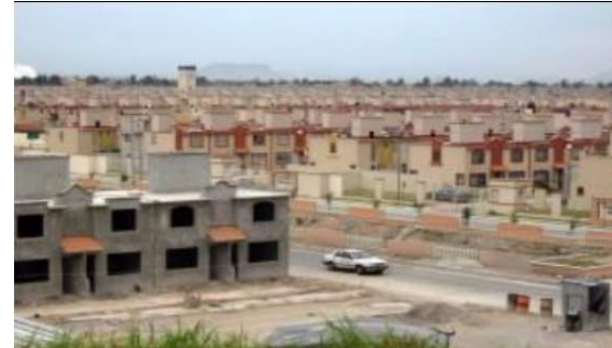
Fotografía de conjuntos habitaciones existentes en la zona
