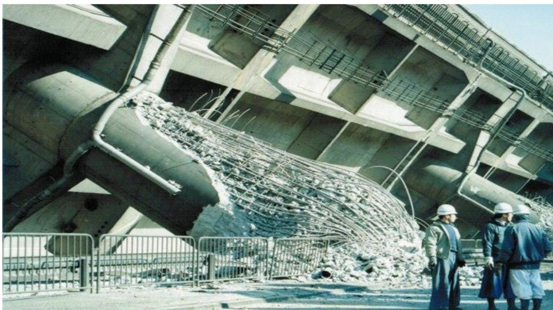
Figura 1.8. Colapso de un paso elevado durante el sismo de Kobe en 1955, esta falla es atribuida entre otras cosas al poco acero de confinamiento.
