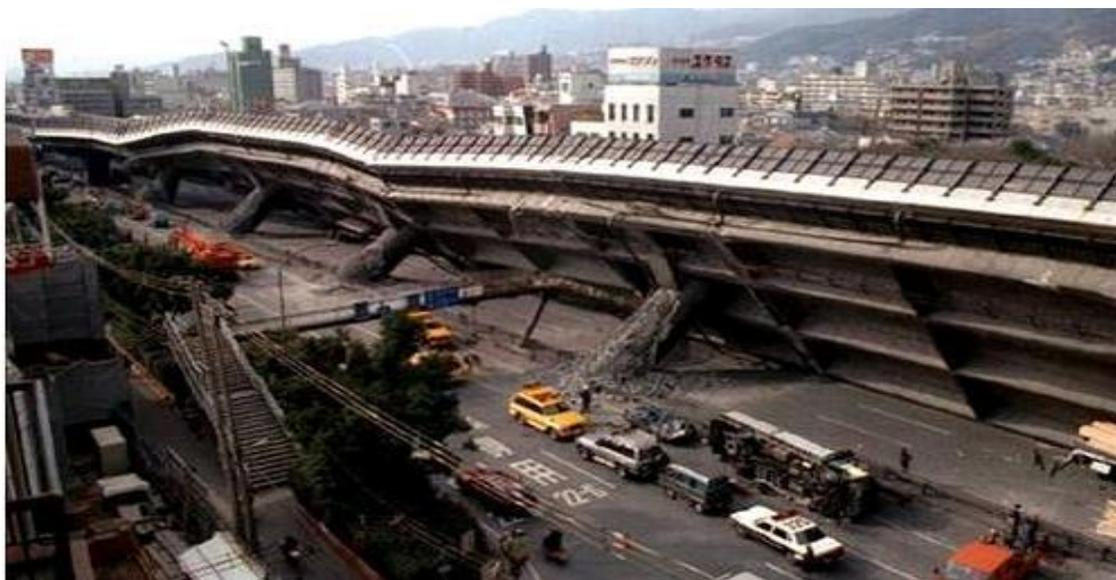
Figura 1.6. Daño en un paso elevado durante el sismo de Kobe en 1995.
