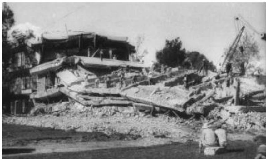
Figura 1.11. Colapso del ala sur del edificio del IPN a causa del sismo de 1957
