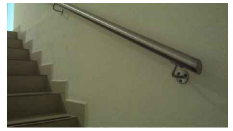
PASAMANOS DE ACERO INOXIDABLE DE 2" DE DIAMETRO PULIDO, FIJADO A MURO, PARA ESCALERAS
