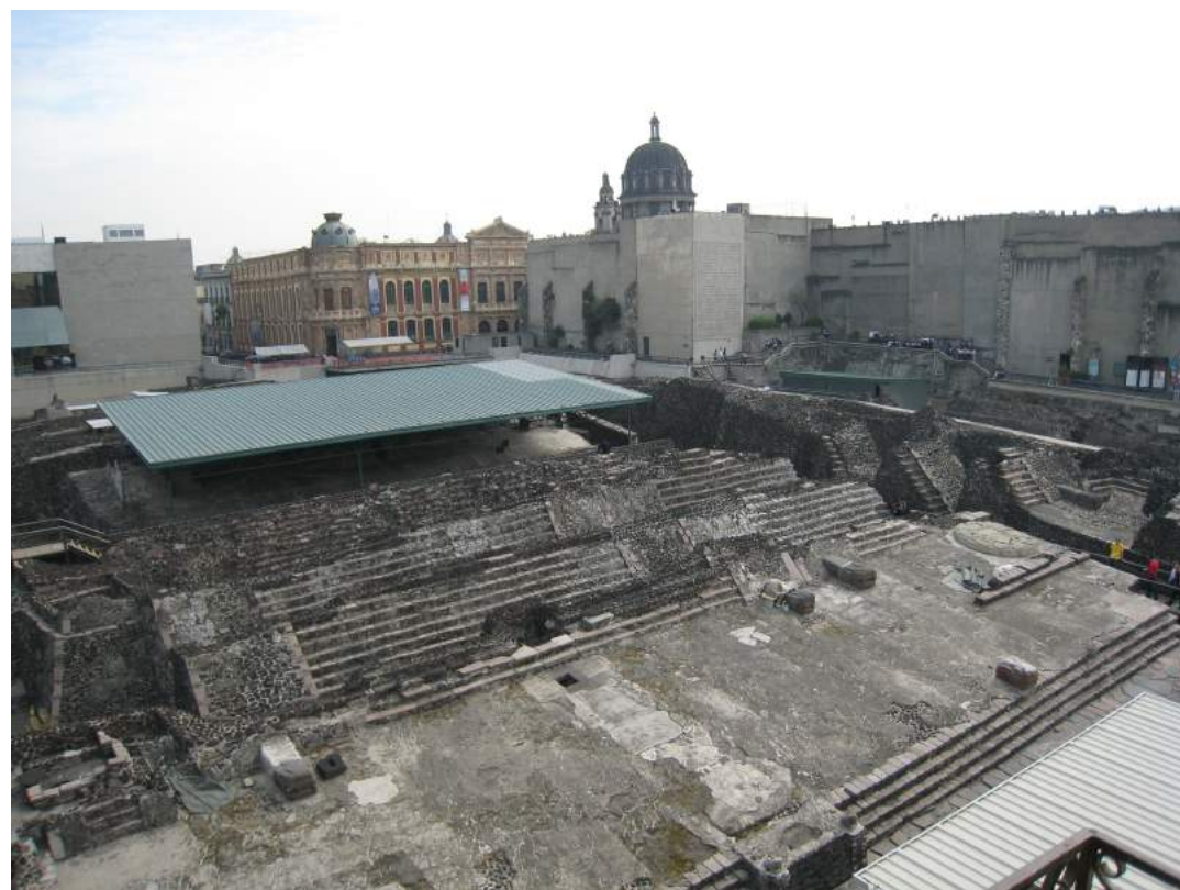
Muros colindantes afectados
