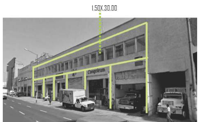
SE GENERA UN VAND A LO LARGO DE TODA LA FACHADA QUE CONTRASTA CON LOS HUECOS DE LA PARTE COMERCIAL
