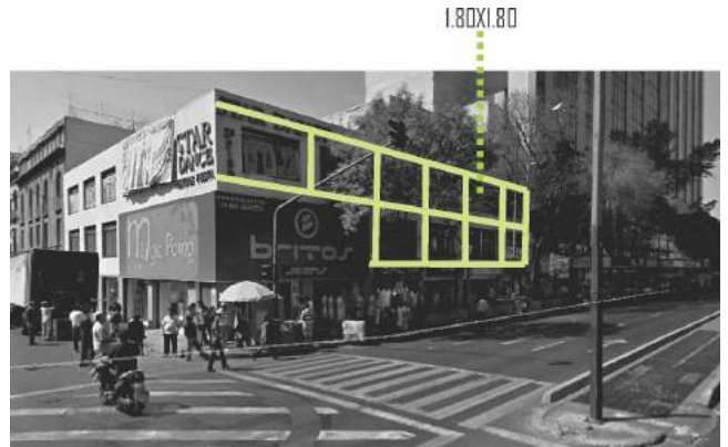
PREDOMINA EL VAND EN EL ELEMENTO ARQUITECTÓNICO, LAS DIMENSIONES DE LOS HUECOS SON LAS MISMAS ESTO GENERA UNA SIMETRÍA
